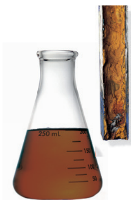
Corrosion perforante, rouille et eau brune dans un réseau non protégé.
