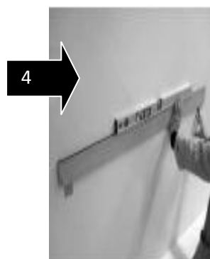
4 Placer la deuxième patte murale en l'alignant de niveau avec la première Place the second wall plate aligning it with the first one
