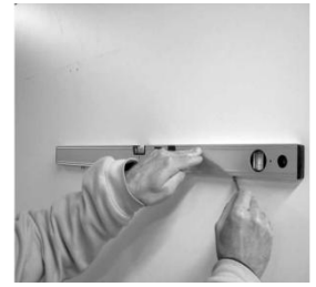
4 Placer la deuxième vis en l'alignant de niveau avec la première Place the second screw aligning it with the first one
